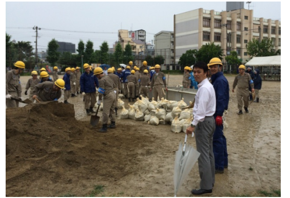
一袋30～50kgの土を詰めての作業
